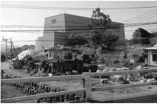
今も倒壊建物の解体作業が続く益城町
