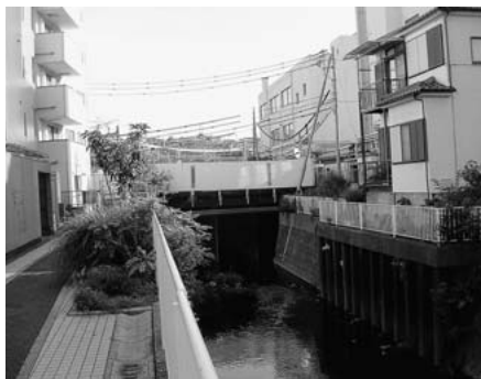
今井川と改修工事現場
